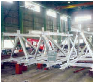
製品組立状況
